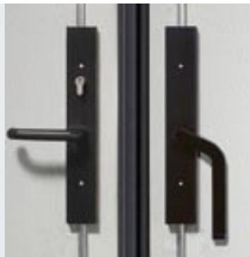
Der Verschluss, die Verriegelung und die Drückergarnitur sind auf dem Torflügel montiert.
