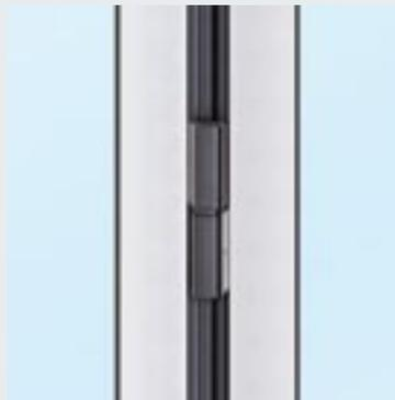
Die schwarzen Bänder sind serien-mäßig zwischen den Torflügeln in gleicher Flucht mit den Dichtungen montiert.
