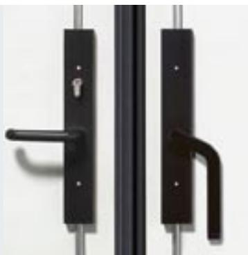
Der Verschluss, die Verriegelung und die Drückergarnitur sind auf dem Torflügel montiert.
